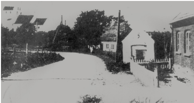
Sprøjtehuset i Ubberud, nedrevet 1958
