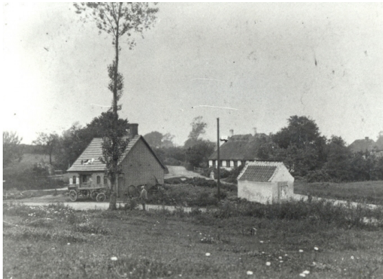
Sprøjtehuset i Korup, nedrevet ca. 1971
