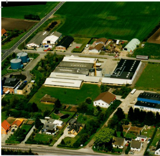
Midt i billedet den nybyggede Korup Stolefabrik, Sandvadvej 3
